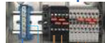
Elektronická jednotka Giacomini PM100 CZ, propojí termostaty s termoelektrickým ventilem s regulační hlavíčí
