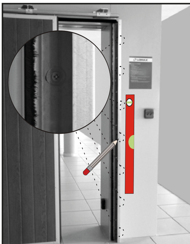
16. Po odsunutí vrat stranou, naznačíme kotvicí otvory a sloupek pevně přišroubujeme.
