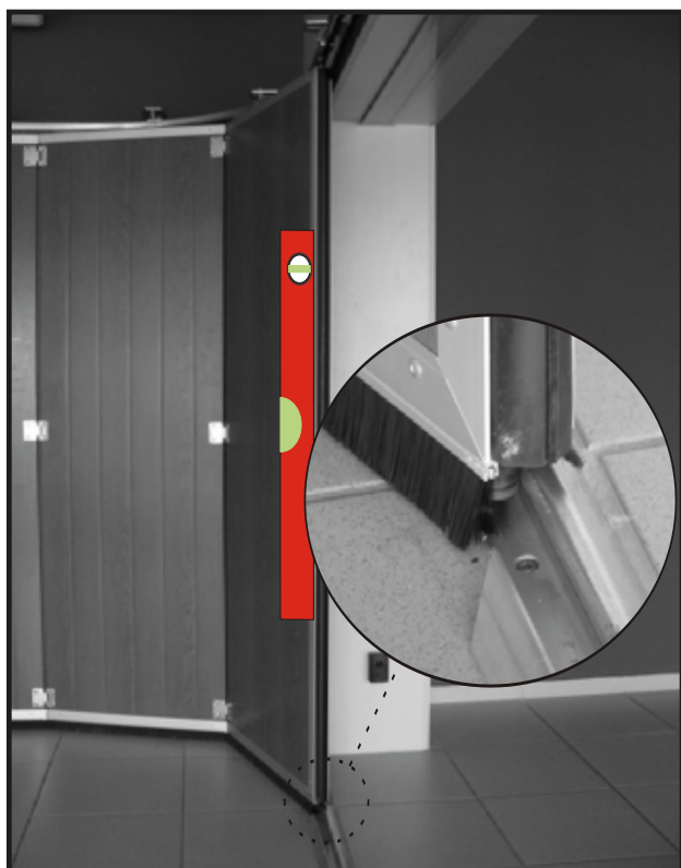
20. Pokud máme přikotvenou spodní přejezdovou lištu, vyzkoušíme jestli při zavření vratového křídla nabíhají všechny naváděcí válečky do drážky přejezdové lišty. Vůle mezi válečkem a spodní lištou se doporučuje 3mm.
