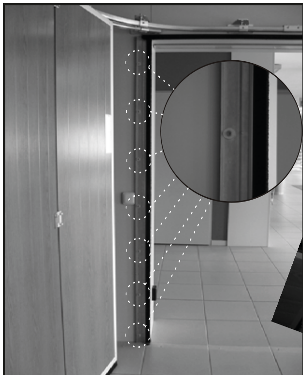
18. Následně přikotvíme těsnicí profil s kartáčem na straně od-suvu vrat a to tak, aby kartáč nevyčníval do otvoru.
