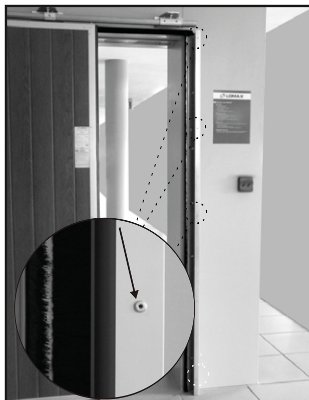
17. Přiložíme AL. U profil, který přinýtujeme k sloupku pomocí přibalených nýtů.
