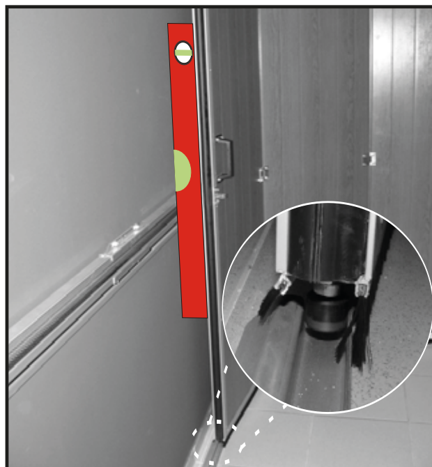
22. Naváděcí válečky musí ve vodící kolejnici jezdit tak aby ne-drhly a ani nevyjížděly ven z kolejnice. Panely musí být visle dolů.
